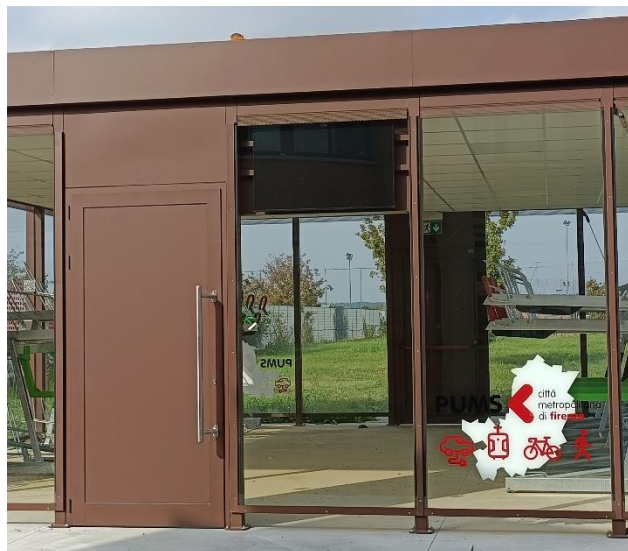
Figura 12 – Ciclostazione dettaglio Monitor
