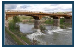
Adeguamento Ponte sulla SP106
