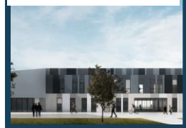
Nuovo Edificio San Salvi
