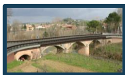
Adeguamento Ponte SP64 Km 7+700
